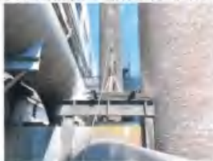
图 11 炒渣机+冷灰桶排气筒出口
