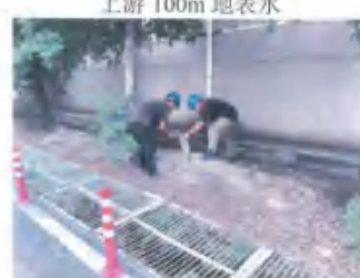
图 21 ■1 改建熔铸车间东北侧 土壤
